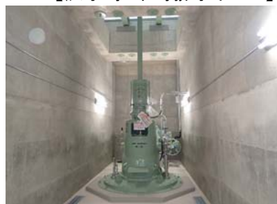
【洪水時排水ポンプ設備】施工状況(組立中)
