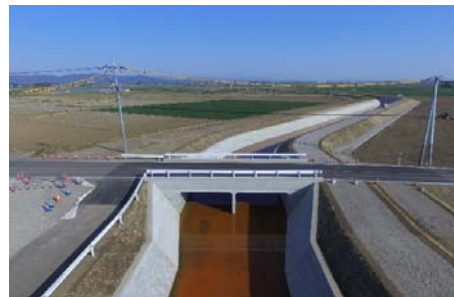
【暗渠工(県道横断)施工中】
