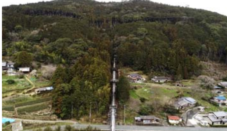
【1号サイホン上流側】
