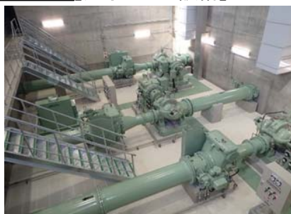
【洪水時排水ポンプ設備】施工状況 (吸込ベル)※鋼製型枠施工状況
