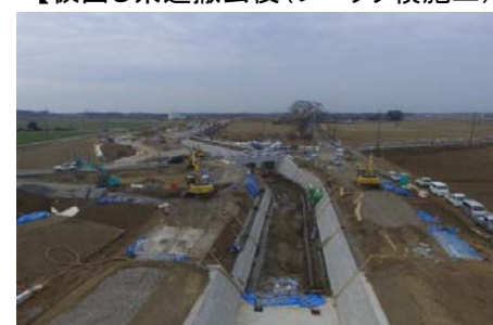
【仮回し県道撤去後(ブロック積施工)】
